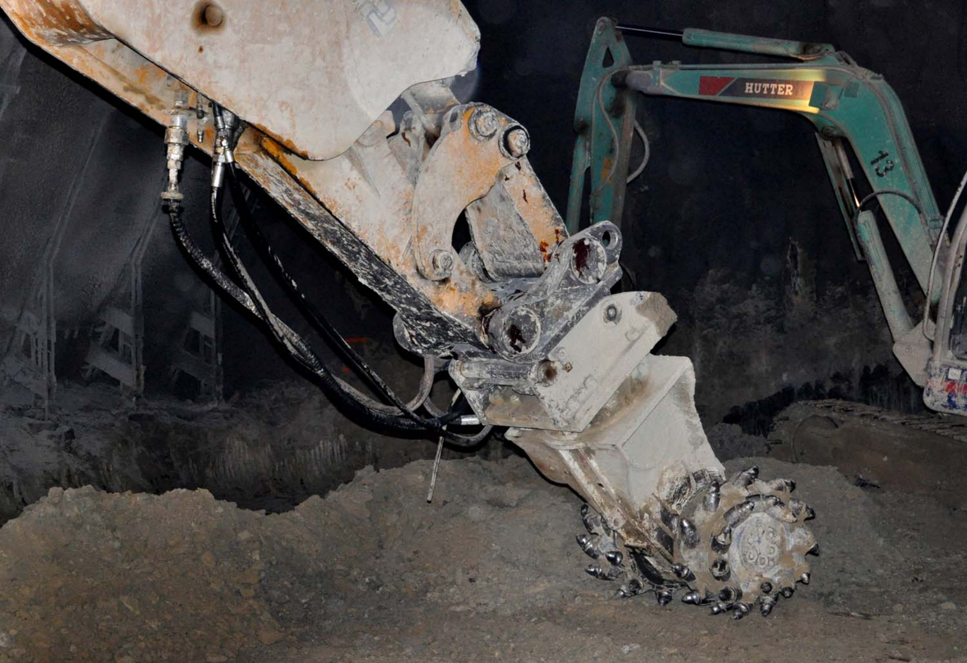
A16 - Tunnel Sous le Mont, Tavannes Haveuse, machine attaque ponctuelle (12.09.09)
